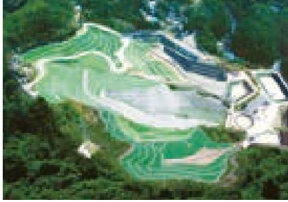
明和クリーン管理型処分場
