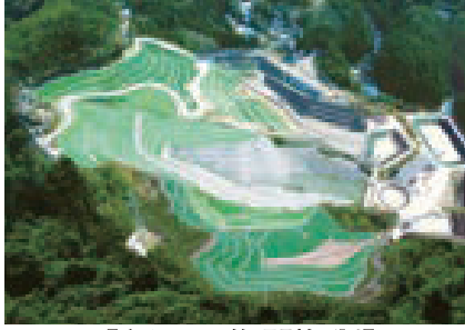
明和クリーン管理型処分場
